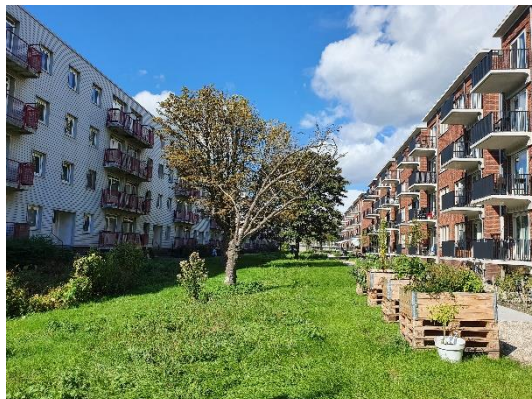
Foto 5: project Welschen 2 (rechts)
