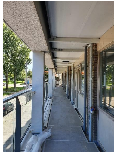
Foto 3: renovatie en verduurzaming Prinsessenflats (galerij)
