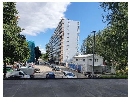
Foto 4: renovatie en verduurzaming prinsessenflats
